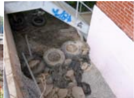
Figure 18 : Mur de pneus, imperméabilisation et drainage de la fosse
