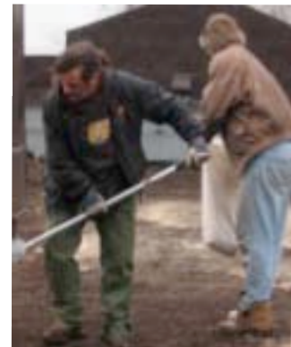
Figure 7 : Ratissage et pose de colle
