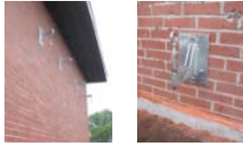
Figure 20 : Détails des ancrages
