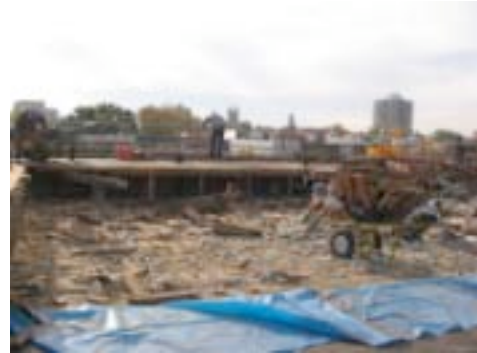
Figure 3 Démontage des entretoits
