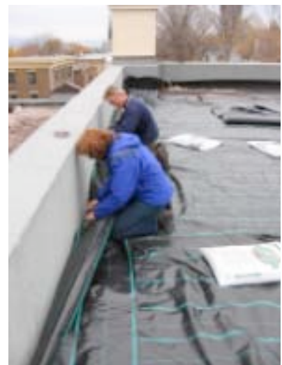
Figure 5 : Pose du matelas capillaire
